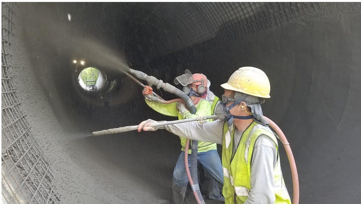
TORKRET QUICK BETON TM «ВосЦем» - полностью готовая к применению (после затворения водой) сухая полифракционная смесь из высококачественного бездобавочного портландцемента, наполнителя на базе
