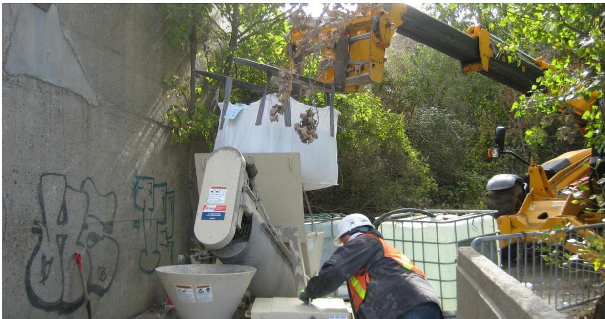
Высокая температура окружающей среды или материалов, низкая относительная влажность, солнечная радиация и ветер могут сильно повлиять на качество торкрет-бетона, поскольку ускоряет потерю влаги и увеличивает скорость гидратации цемента, снижает удобоукладываемость и прокачиваемость бетона, повышает риски растрескивания поверхности из-за усадки, снижает прочность на сжатие.
